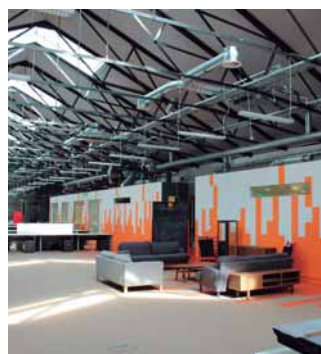
La solución de Zalando para la conversión de su oficina de almacén en Grand Canal Quay, Dublin. ECOi
